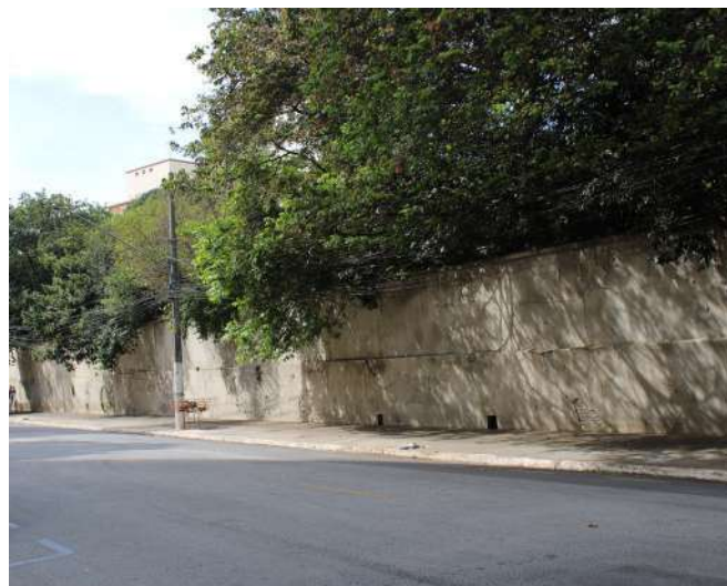
fig 166. Trecho da face externa do Muro voltado para a Rua Mato Grosso. Data: 22/05/2023.
