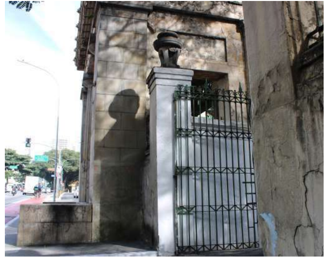
fig 63. Vista Lateral Direita do Pórtico Frontal. Data: 22/05/2023.
