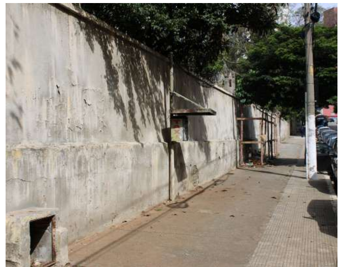
fig 160. Trecho da face externa do Muro voltado para a Rua Mato Grosso. Data: 22/05/2023.
