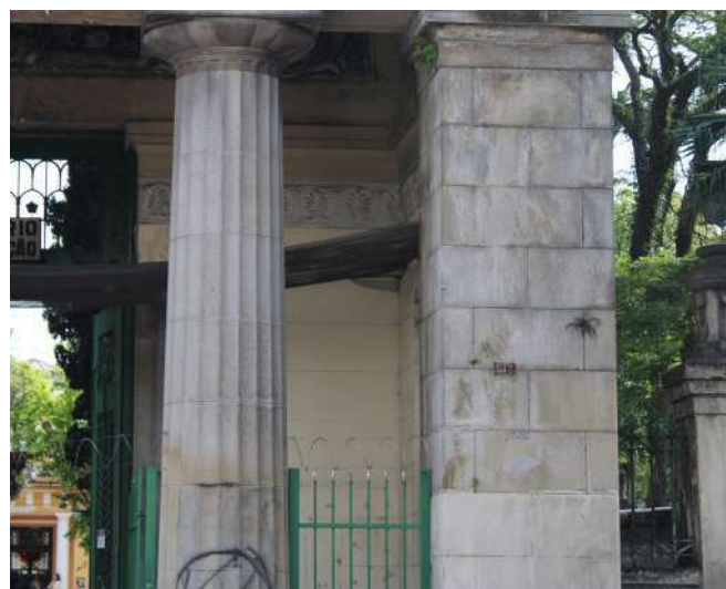
fig 53. Ampliação: pilastra e coluna dórica, trecho direito do Pórtico Frontal, Vista Frontal. Data: 22/05/2023.
