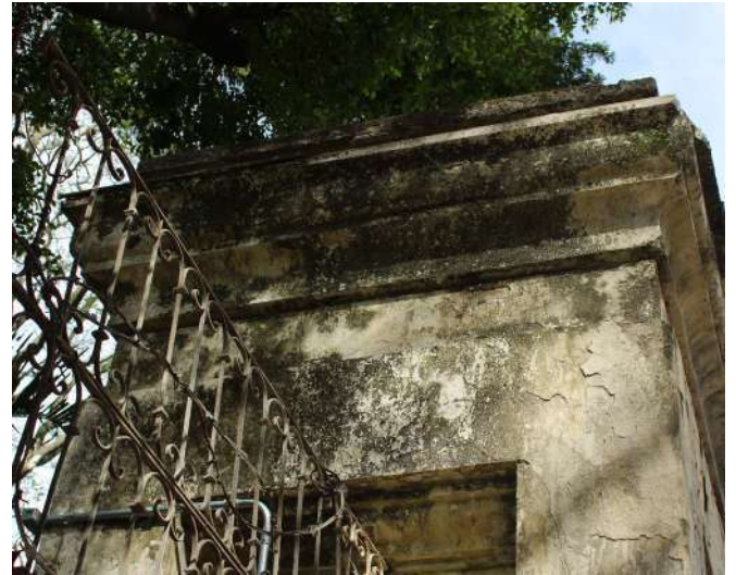
fig 143. Detalhe das cornijas na lateral esquerda do Pórtico Posterior. Data: 22/05/2023.
