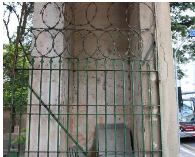
fig 155. Faces internas das colunas que estruturam o Pórtico Posterior. Data: 22/05/2023.
