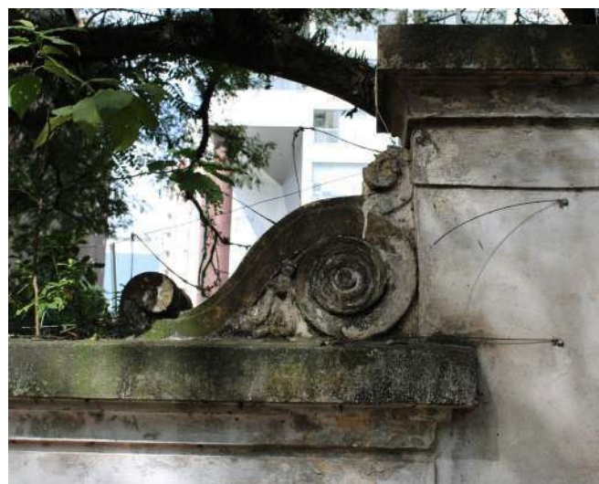
fig 208. Detalhe de uma das volutas encontradas a cada diferença de nível entre os trechos do Muro voltados para a Rua da Consolação. Data: 22/05/2023.
