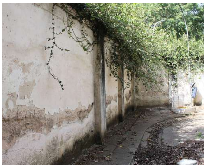
fig 201. Trecho da face interna do Muro na altura da esquina entre as Ruas Sergipe e Consolação. Data: 22/05/2023.
