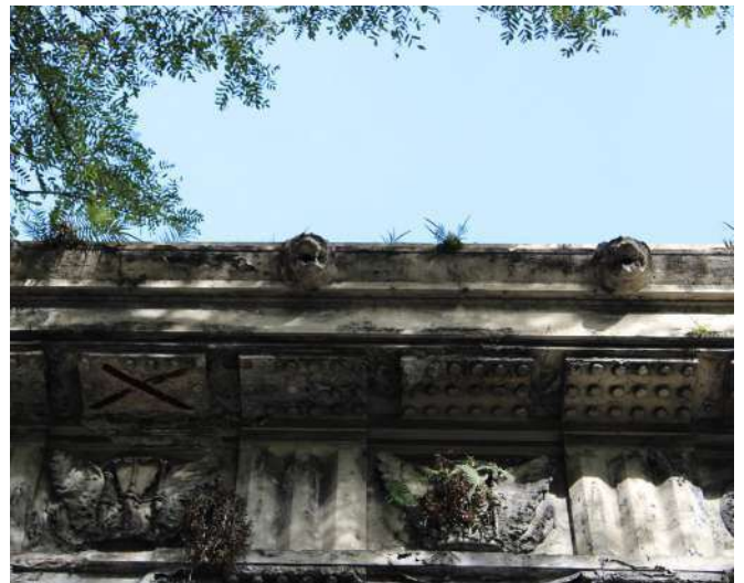
fig 70. Detalhes das gárgulas e réguas com gotas. Pórtico Frontal, Vista Lateral Direita. Data: 22/05/2023.
