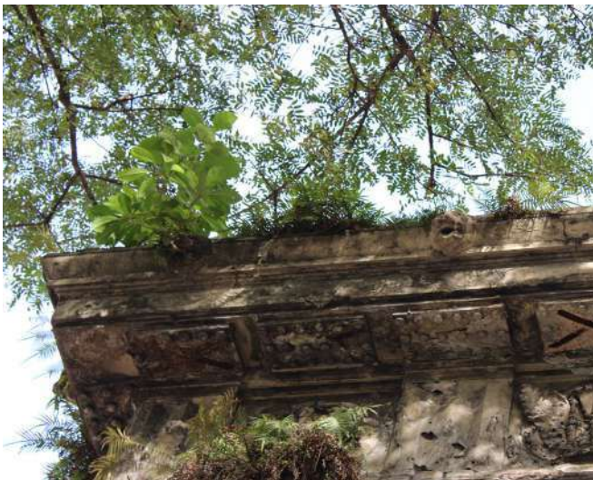
fig 69. Detalhes das gárgulas e réguas com gotas. Pórtico Frontal, Vista Lateral Direita. Data: 22/05/2023.
