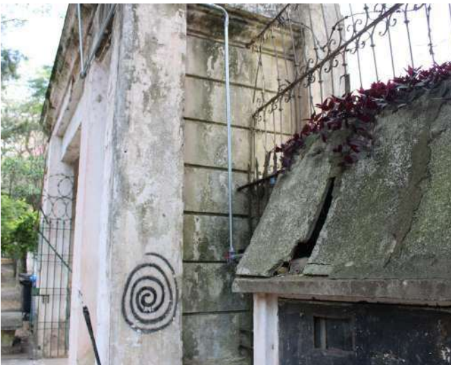
fig 144. Vista Lateral Esquerda do Pórtico Posterior. Data: 22/05/2023.
