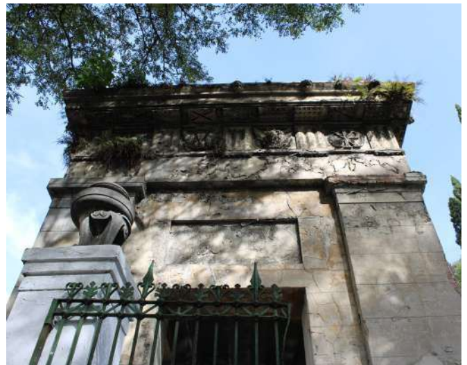
fig 65. Vista Lateral Direita do Pórtico Frontal. Data: 22/05/2023.
