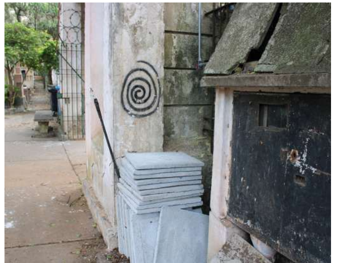
fig 145. Vista Lateral Esquerda do Pórtico Posterior. Data: 22/05/2023.
