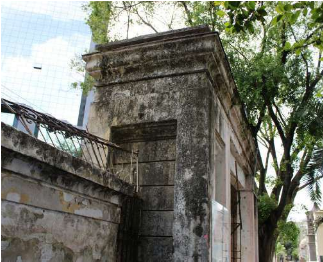
fig 132. Vista Lateral Direita do Pórtico Posterior. Data: 22/05/2023.
