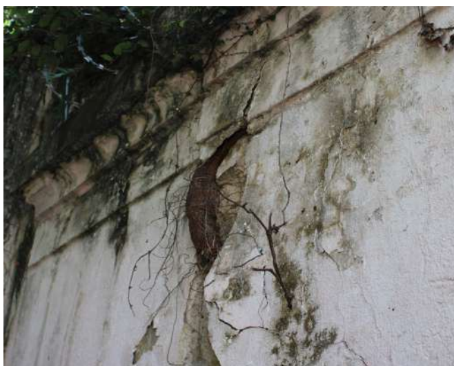
fig 267. Exemplo de vegetação infestante em estágio avançado com as raízes já bastante desenvolvidas. Data: 22/05/2023.
