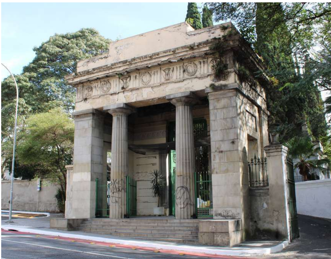
fig 43. Registro fotográfico atual da Vista Frontal do Pórtico, março de 2023. Nota-se a preservação das características originais do Pórtico. Autoria: Taira Almeida.
