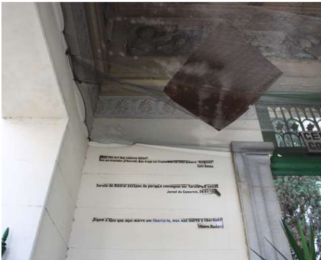
fig 107. Trecho superior das alvenarias do Átrio, Pórtico Frontal. Data: 22/05/2023.
