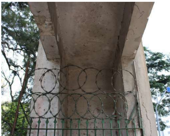
fig 154. Faces internas das colunas que estruturam o Pórtico Posterior. Data: 22/05/2023.
