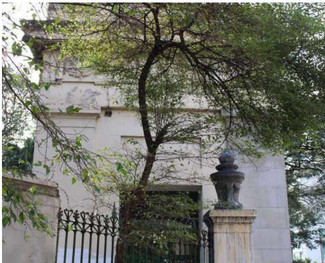
fig 84. Vista Lateral Esquerda do Pórtico Frontal. Data: 22/05/2023.
