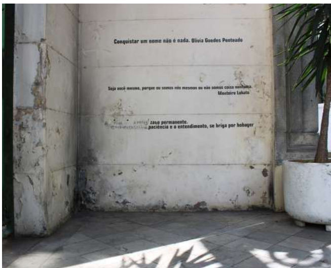
fig 109. Trecho inferior das alvenarias do Átrio, Pórtico Frontal. Data: 22/05/2023.
