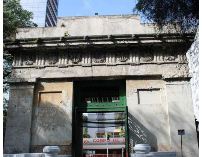
fig 73. Vista Posterior do Pórtico Frontal. Data: 22/05/2023.
