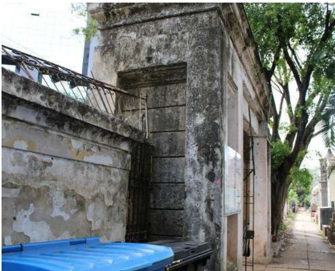
fig 134. Vista Lateral Direita do Pórtico Posterior. Data: 22/05/2023.
