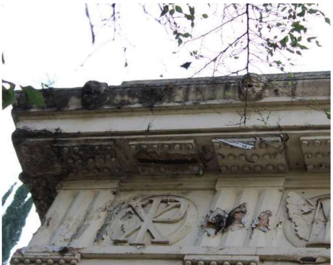
fig 86. Detalhes das gárgulas e régulas com gotas. Pórtico Frontal, Vista Lateral Esquerda. Data: 22/05/2023.
