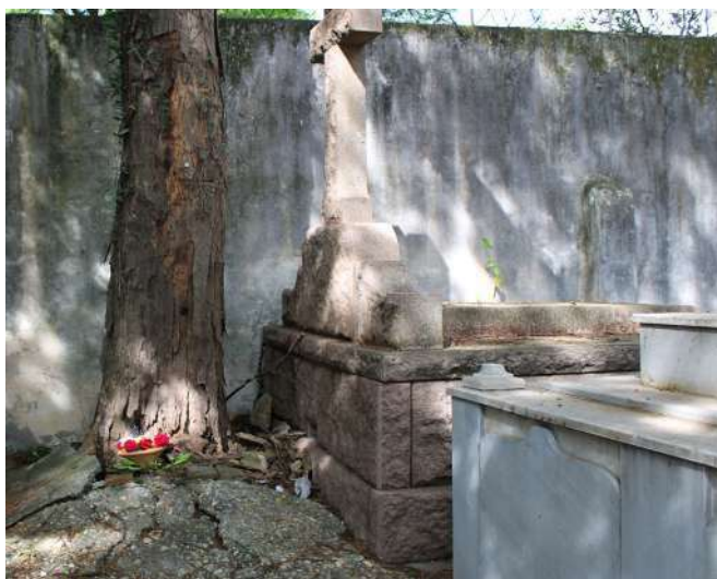
fig 183. Trecho inicial do Muro que divide os Cemitérios da Consolação e dos Protestantes. Data: 22/05/2023.
