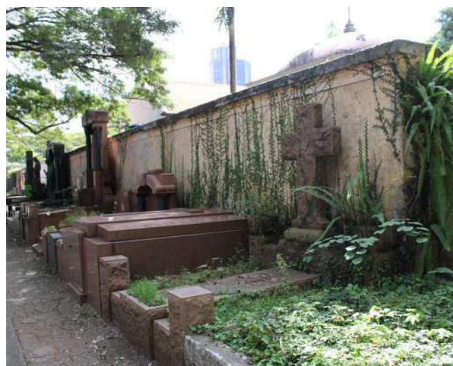
fig 188. Trecho do Muro que divide os Cemitérios da Consolação e dos Protestantes. Data: 22/05/2023.
