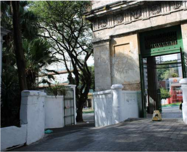
fig 77. Configuração da entrada principal vista do lado dentro do Cemitério. Data: 22/05/2023.
