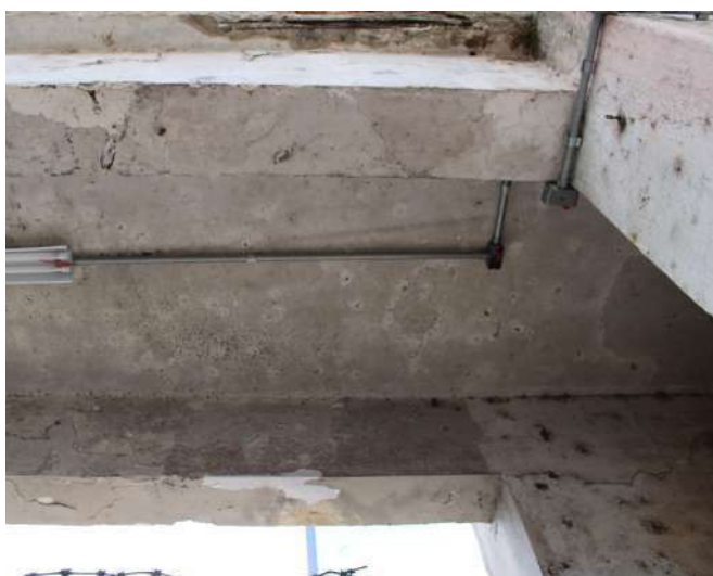
fig 149. Faces inferiores das vigas que estruturam o Pórtico Posterior. Data: 22/05/2023.
