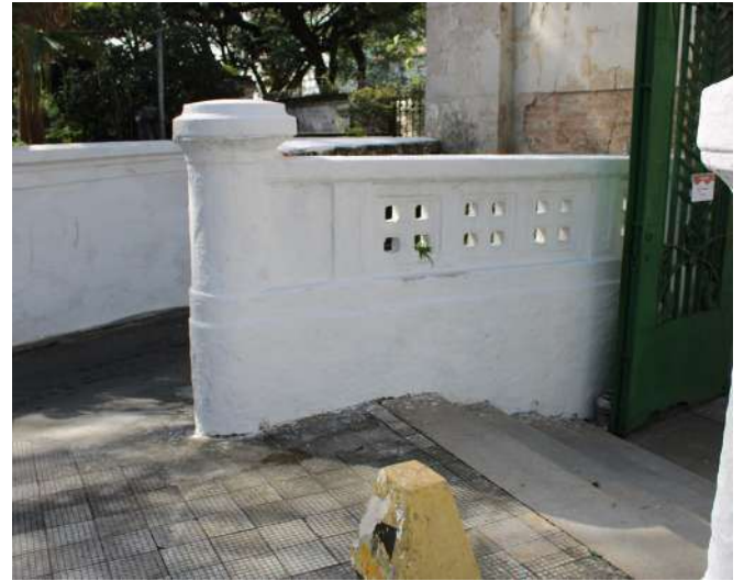
fig 78. Detalhe do canteiro localizado junto à Fachada Posterior do Pórtico Frontal. Data: 22/05/2023.
