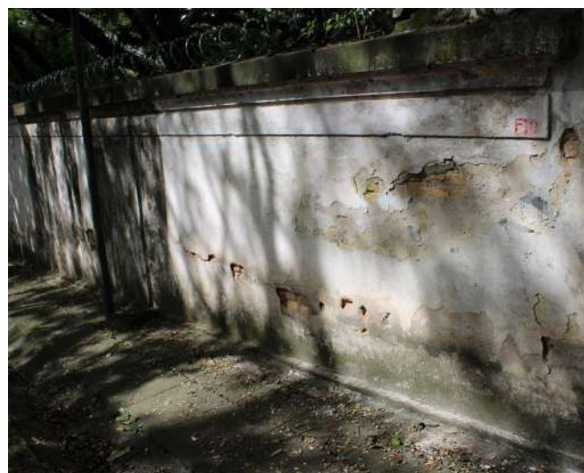
fig 206. Trecho da face interna do Muro voltado para a Rua da Consolação. Data: 22/05/2023.
