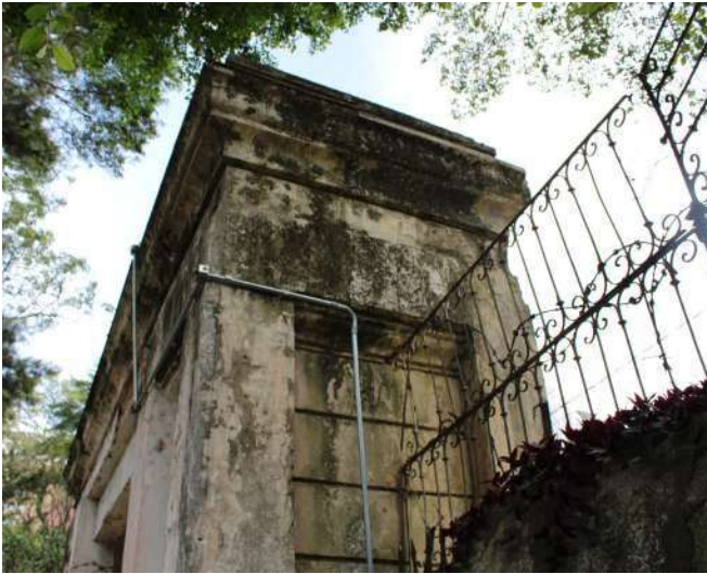
fig 142. Vista Lateral Esquerda do Pórtico Posterior. Data: 22/05/2023.
