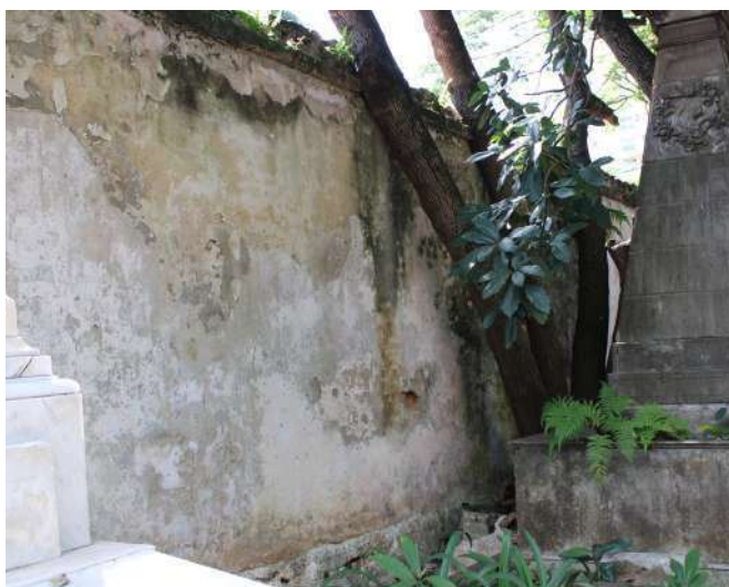
fig 261. Manchas de coloração escura indicando a presença de umidade e colonizações biológicas. Nota-se a proximidade da árvore com o muro. Data: 22/05/2023.
