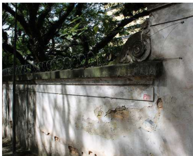
fig 207. Trecho da face interna do Muro voltado para a Rua da Consolação. Data: 22/05/2023.
