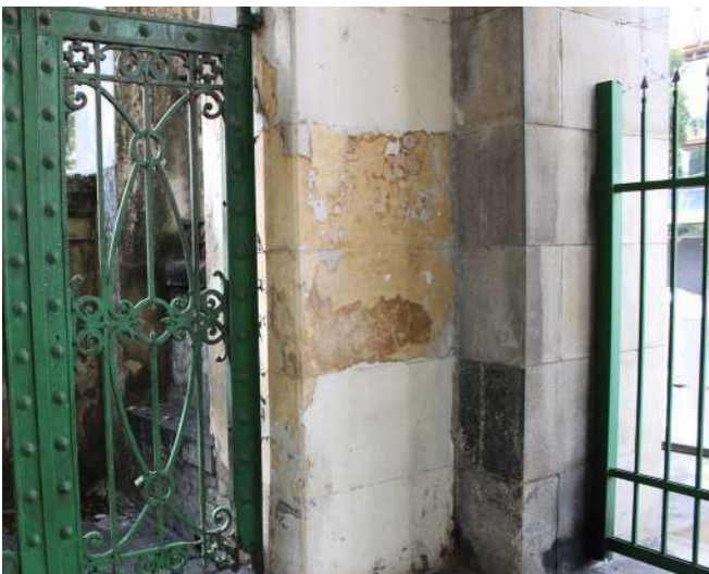
fig 101. Detalhada argamassa em trecho com descascamento de pintura. Átrio, Pórtico Frontal. Data: 22/05/2023.
