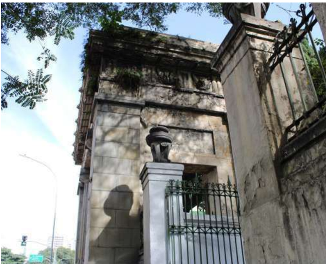
fig 64. Vista Lateral Direita do Pórtico Frontal. Data: 22/05/2023.
