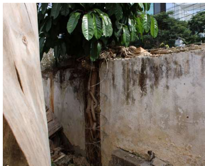
fig 238. Exemplo de vegetação infestante de grande porte em estágio avançado com as raízes já bastante desenvolvidas. Data: 22/05/2023.
