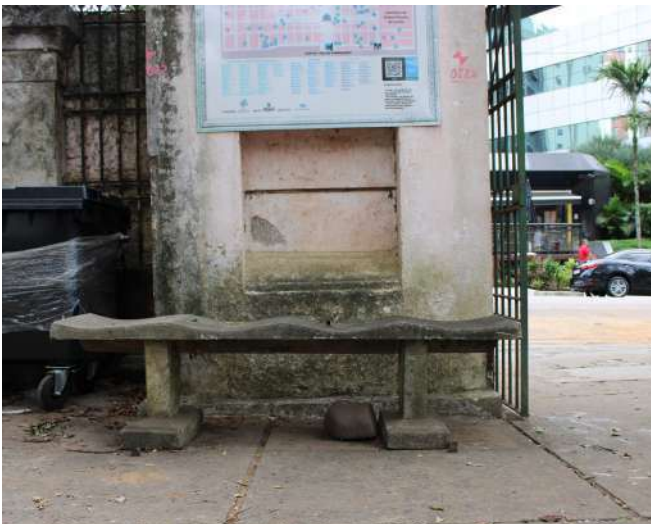
fig 141. Detalhe do trecho inferior da coluna direita do Pórtico Posterior, Vista Posterior. Data: 22/05/2023.
