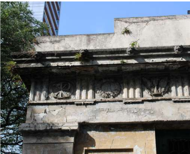
fig 74. Ampliação do entablamento do Pórtico Frontal, Vista Posterior. Data: 22/05/2023.
