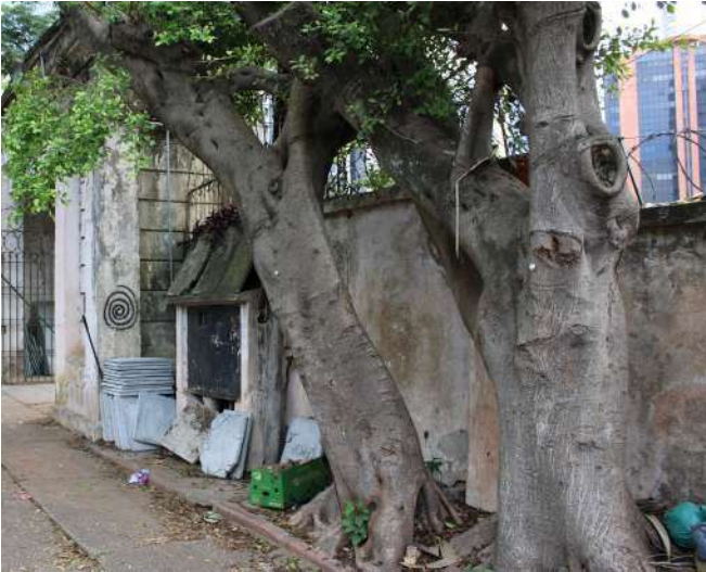
fig 169. Trecho da face interna do Muro voltado para a Rua Mato Grosso, ao lado do Pórtico Posterior. Data: 22/05/2023.
