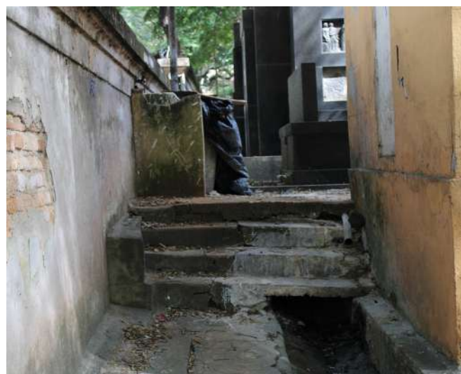
fig 210. Detalhe da escada encontrada junto à face interna do Muro voltado para a Rua da Consolação. Data: 22/05/2023.
