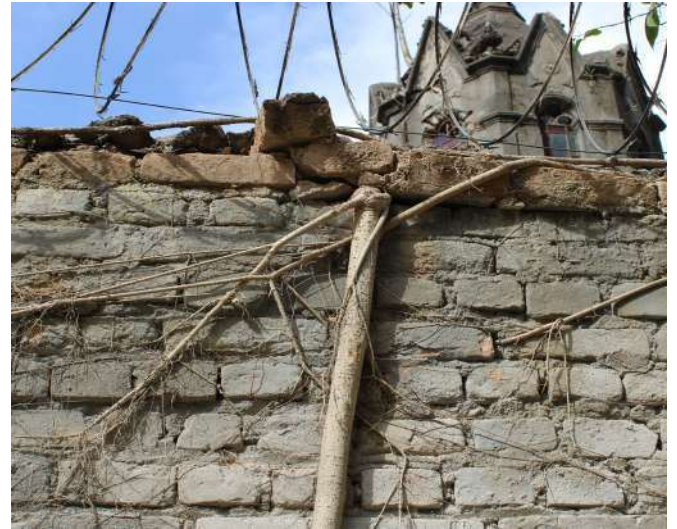
fig 216. Vegetação infestante: detalhe das raízes. Data: 22/05/2023.
