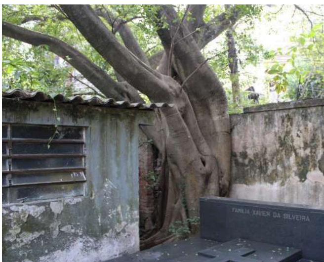
fig 179. Trecho da face interna do Muro na altura da esquina entre as Ruas Mato Grosso e Sergipe. Data: 22/05/2023.
