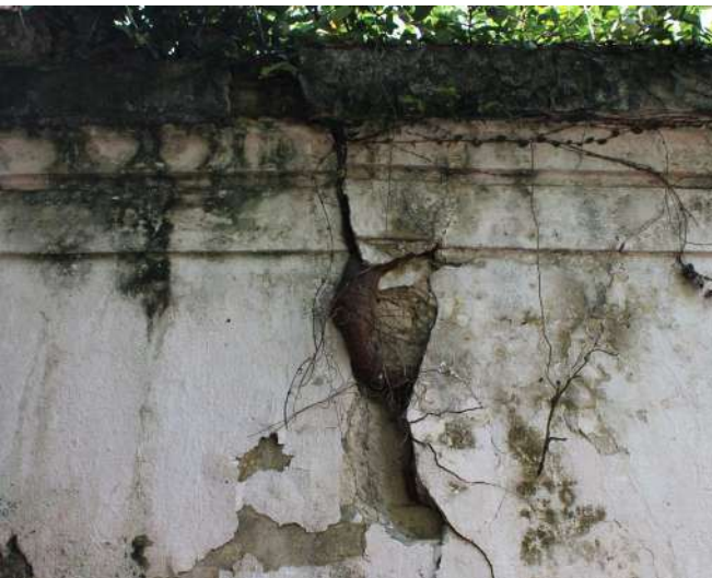
fig 265. Exemplo de vegetação infestante em estágio avançado com as raízes já bastante desenvolvidas. Data: 22/05/2023.
