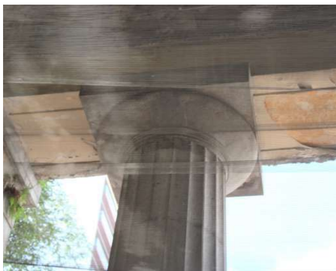
fig 96. Detalhe do capitel dórico, Pórtico Frontal. Data: 22/05/2023.
