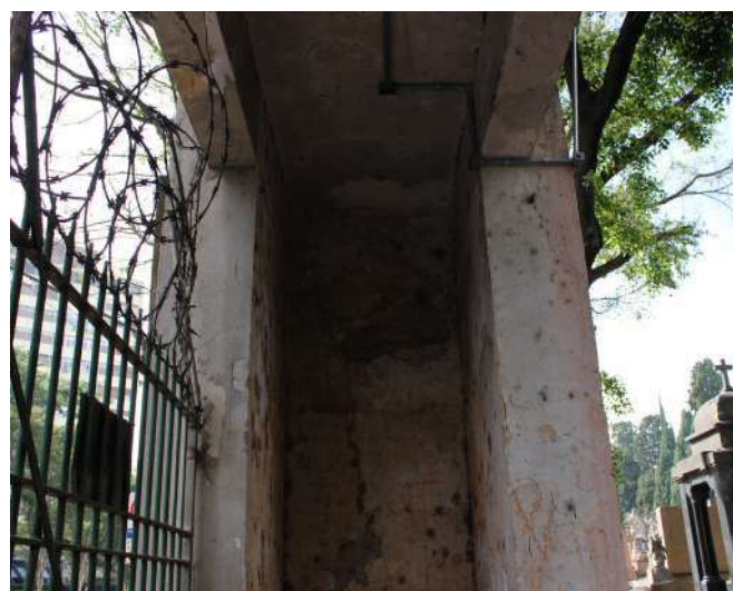
fig 150. Faces internas das colunas que estruturam o Pórtico Posterior. Data: 22/05/2023.
