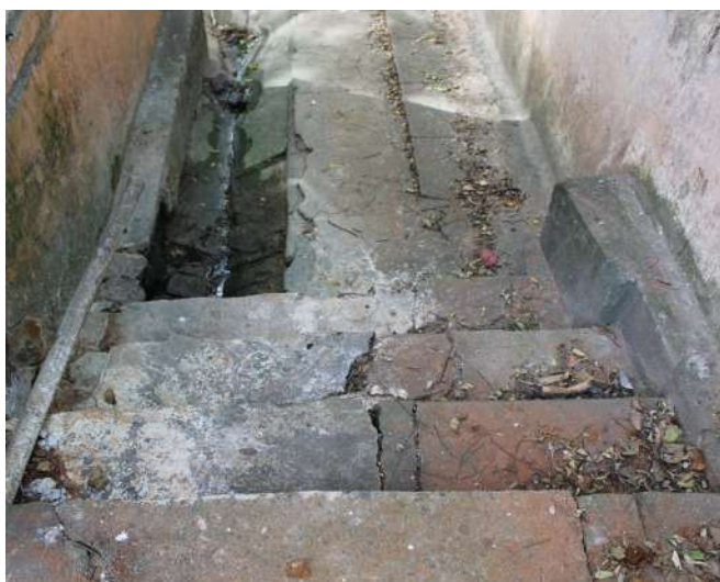
fig 211. Detalhe da escada encontrada junto à face interna do Muro voltado para a Rua da Consolação. Data: 22/05/2023.
