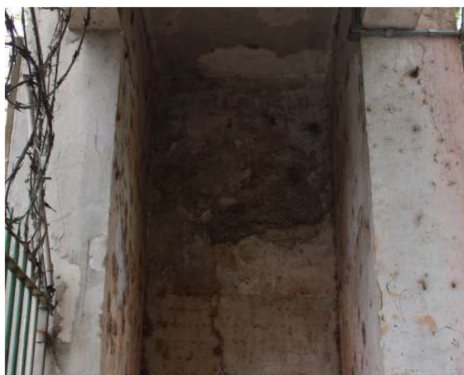
fig 151. Faces internas das colunas que estruturam o Pórtico Posterior. Data: 22/05/2023.
