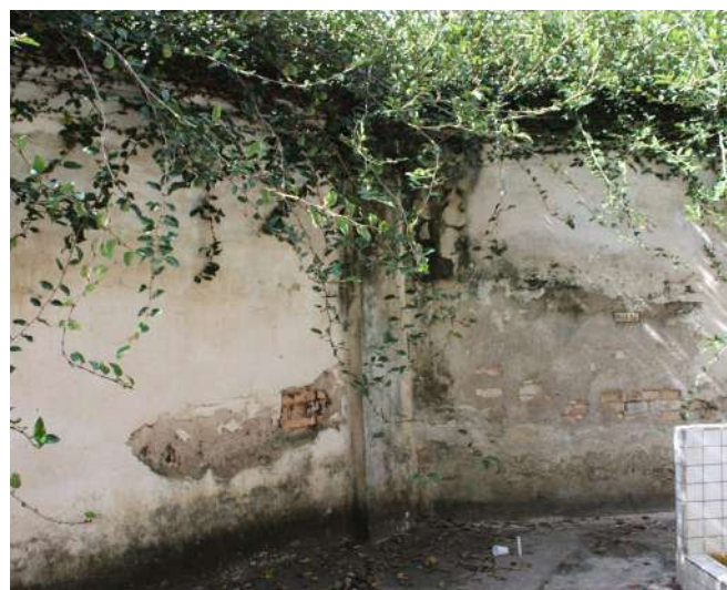
fig 202. Trecho da face interna do Muro na altura da esquina entre as Ruas Sergipe e Consolação. Data: 22/05/2023.
