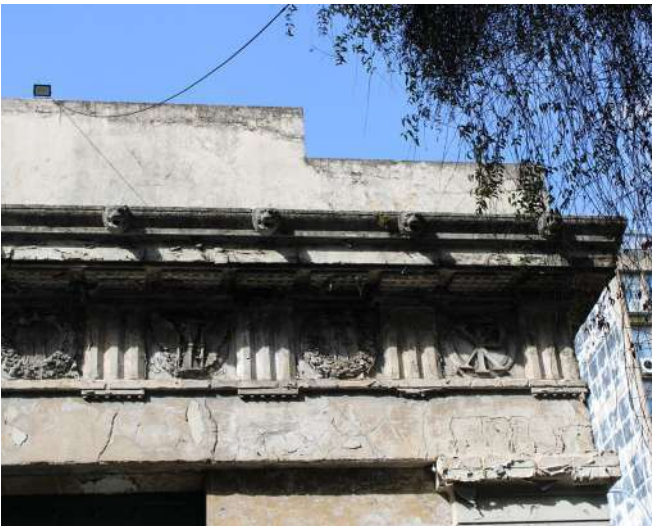
fig 76. Ampliação do entablamento do Pórtico Frontal, Vista Posterior. Data: 22/05/2023.
