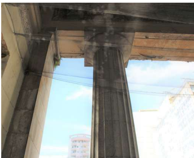
fig 92. Coluna dórica em granito vista do Átrio, Pórtico Frontal. Data: 22/05/2023.
