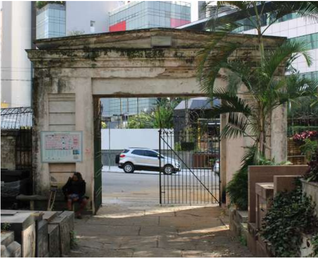
fig 137. Pórtico Posterior visto do lado de dentro do Cemitério. Data: 22/05/2023.
