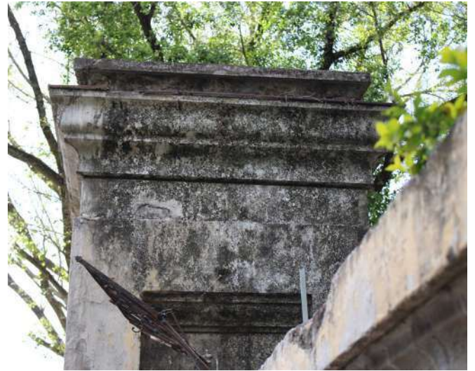
fig 133. Detalhe das cornijas na lateral direita do Pórtico Posterior. Data: 22/05/2023.
