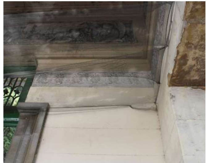
fig 108. Trecho superior das alvenarias do Átrio, Pórtico Frontal. Data: 22/05/2023.
