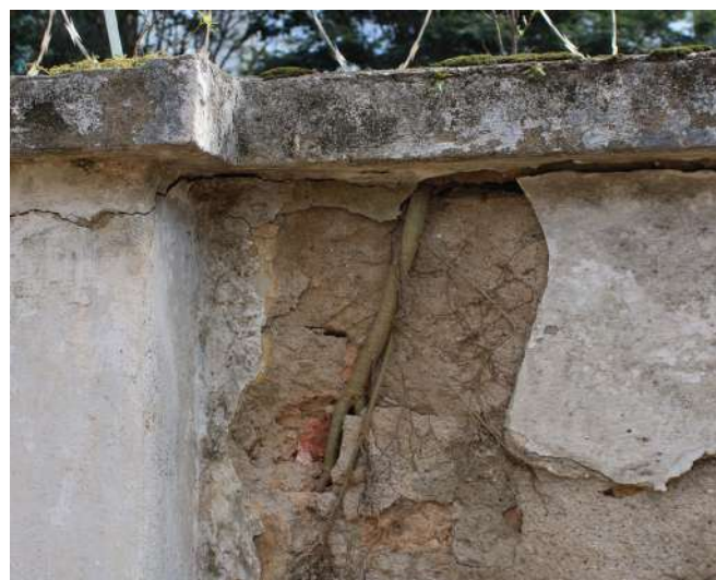
fig 236. Vegetação infestante: detalhe das raízes. Data: 22/05/2023.
