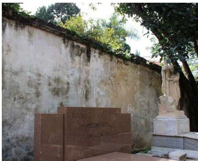
fig 193. Trecho final do Muro que divide os Cemitérios da Consolação e dos Protestantes. Data: 22/05/2023.
