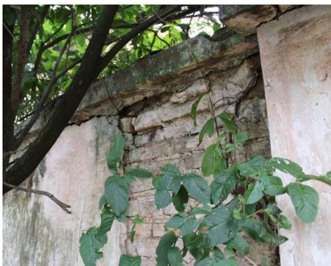
fig 249. Trecho com tijolos expostos e pequenas raízes em desenvolvimento. Data: 22/05/2023.
