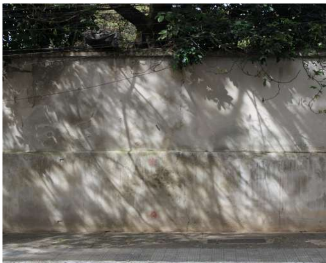
fig 165. Trecho da face externa do Muro voltado para a Rua Mato Grosso. Data: 22/05/2023.
