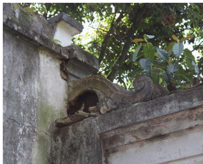
fig 200. Detalhe da voluta encontrada no vértice dos Muros de divisão dos Cemitérios da Consolação e dos Protestantes. Data: 22/05/2023.
