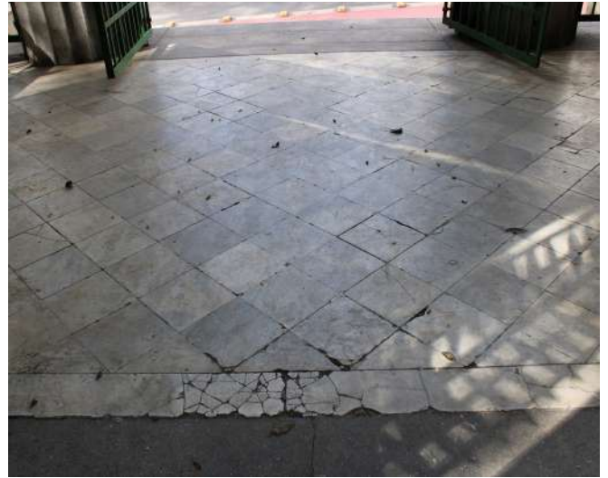
fig 123. Piso em mármore do Átrio, Pórtico Frontal. Data: 22/05/2023.
