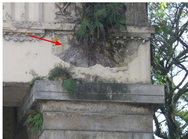
fig 6. Colonização biológica encontrada no entablamento do Pórtico Frontal. Data: 22/05/2023.
