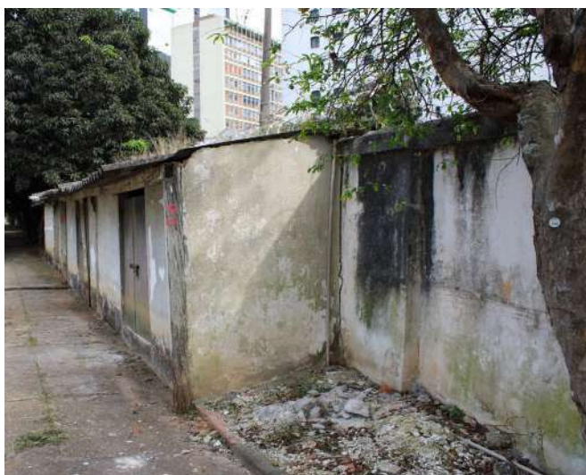
fig 177. Trecho da face interna do Muro voltado para a Rua Mato Grosso, ao lado da construção utilizada como depósito. Data: 22/05/2023.
