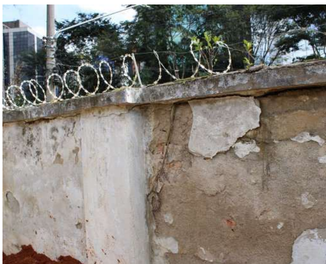
fig 235. Exemplo de vegetação infestante em estágio avançado com as raízes em desenvolvimento. Data: 22/05/2023.
