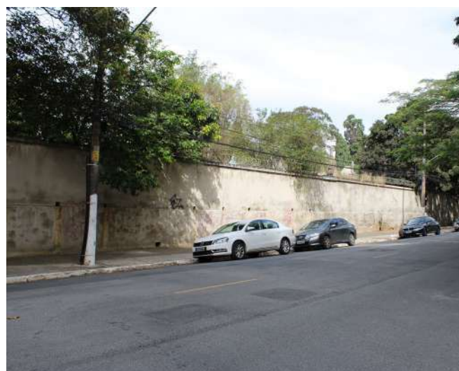
fig 168. Trecho da face externa do Muro voltado para a Rua Mato Grosso. Data: 22/05/2023.
