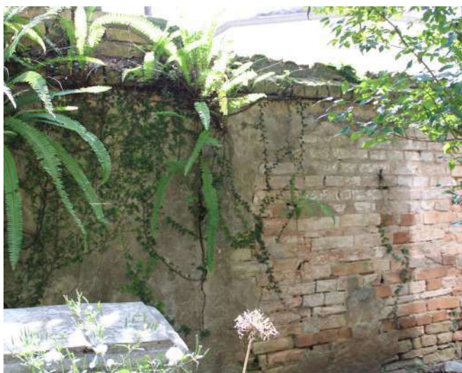
fig 259. Grande trecho com tijolos expostos e presença de vegetações infestantes. Data: 22/05/2023.
