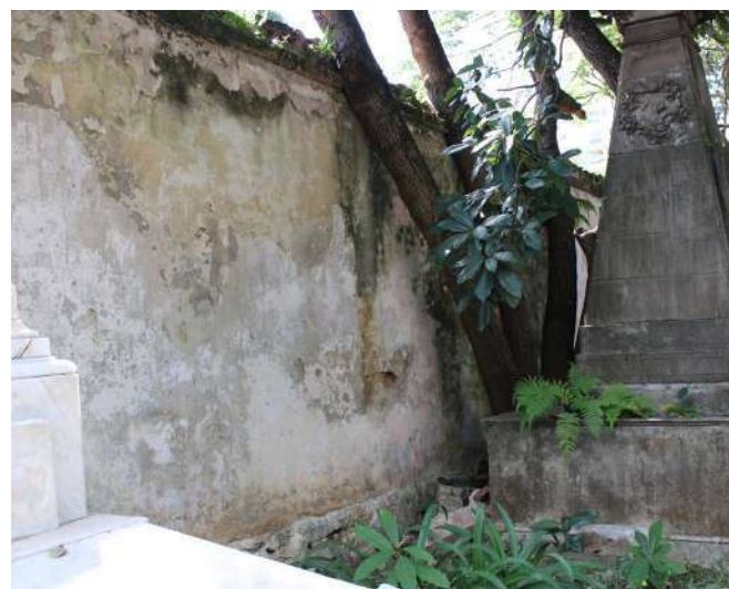
fig 194. Trecho final do Muro que divide os Cemitérios da Consolação e dos Protestantes. Data: 22/05/2023.
