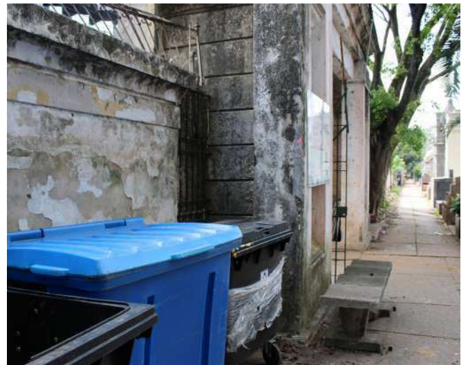
fig 135. Vista Lateral Direita do Pórtico Posterior. Data: 22/05/2023.
