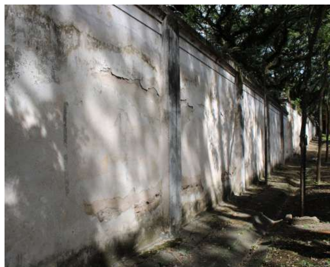
fig 204. Trecho da face interna do Muro voltado para a Rua da Consolação. Data: 22/05/2023.
