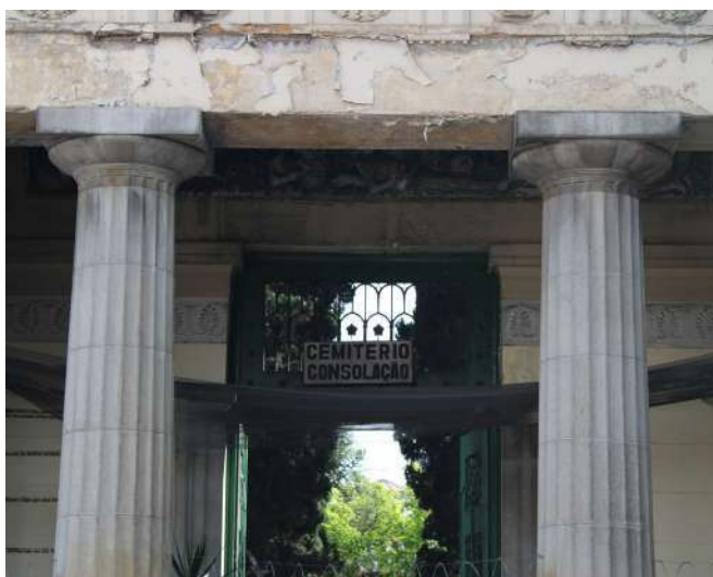
fig 56. Detalhes dos capitéis dóricos e portão de entrada ao fundo. Pórtico Frontal, Vista Frontal. Data: 22/05/2023.
