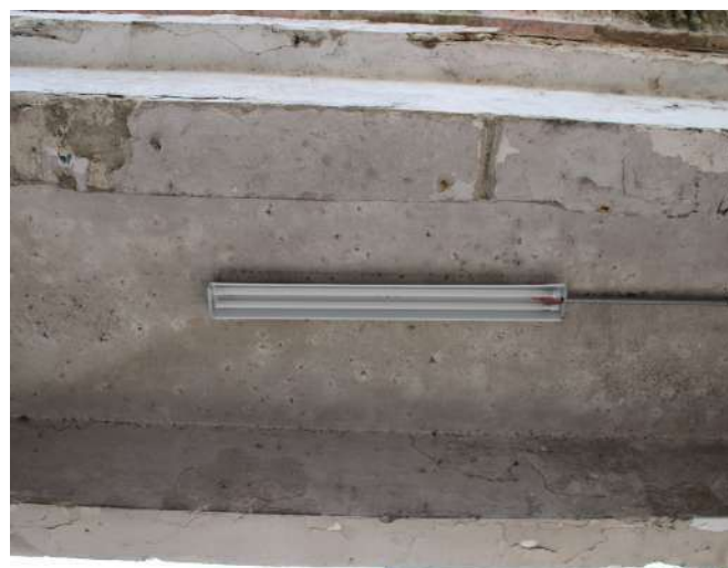
fig 148. Faces inferiores das vigas que estruturam o Pórtico Posterior, com destaque para a iluminação instalada. Data: 22/05/2023.
