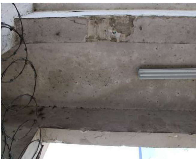
fig 147. Faces inferiores das vigas que estruturam o Pórtico Posterior. Data: 22/05/2023.
