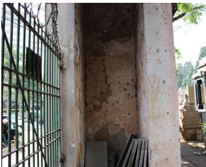
fig 152. Faces internas das colunas que estruturam o Pórtico Posterior. Data: 22/05/2023.
