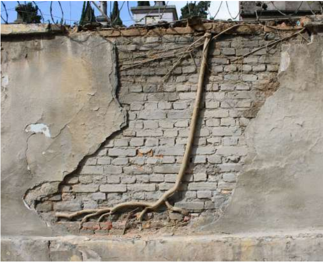
fig 215. Exemplo de vegetação infestante em estágio avançado com as raízes já bastante desenvolvidas. Data: 22/05/2023.
