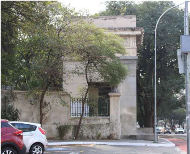
fig 82. Vista Lateral Esquerda do Pórtico Frontal. Data: 22/05/2023.
