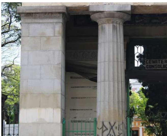
fig 52. Ampliação: pilastra e coluna dórica, trecho esquerdo do Pórtico Frontal, Vista Frontal. Data: 22/05/2023.
